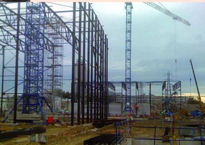
La Cité du Cinéma en construction
